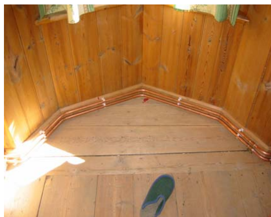
Kupferrohrverlegung Sockelleistenheizung
